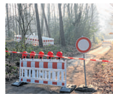
Abgesperrt ist die Straße Am Masling; vorne li. der Tagesbruch. FOTO: SCHILD
