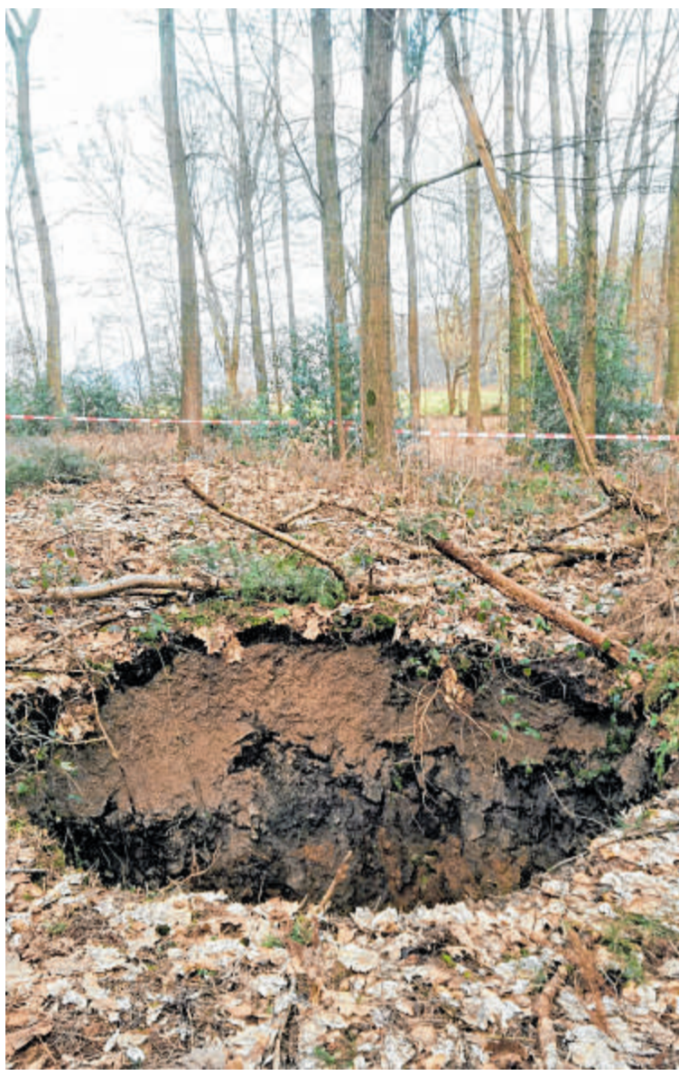
Mitten im Vormholzer Wald tat sich am Dienstagnachmittag dieser Krater auf. Zumindest wurde er da entdeckt. FOTO: VIEHHAUS
