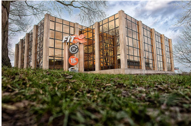
Außenansicht FitX Fitnessstudio Essen-Bergerhausen
