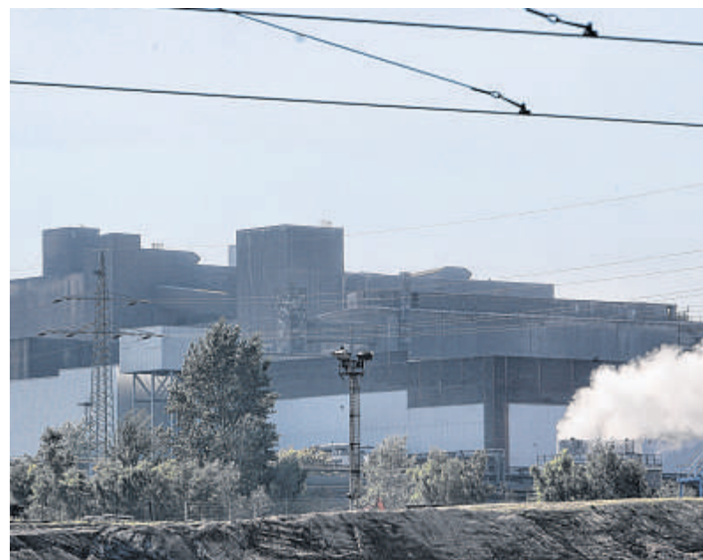
Rauchen sollen die Schornsteine in Bochumer nur noch bis Ende 2014. Die IG Metall sagt, der aktuelle Engpass zeige, wie wichtig das hiesige Stahlwerk ist. FOTO: S. AREND
